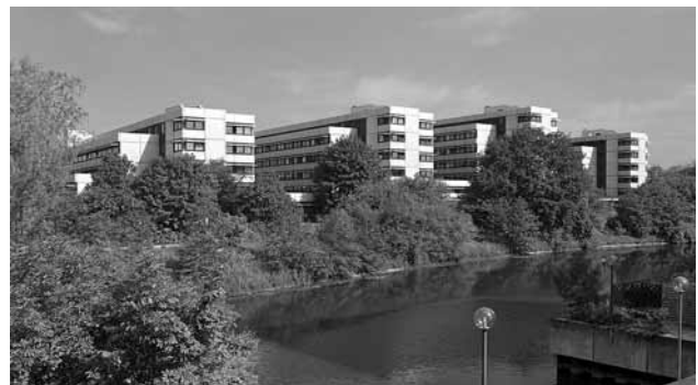
John Foulks' Wirkungsstätte, die Fakultätenblöcke an der Leibnizstraße. Im Vordergrund der »See der Biologen«. Foto: Jürgen Haacks / Uni Kiel
